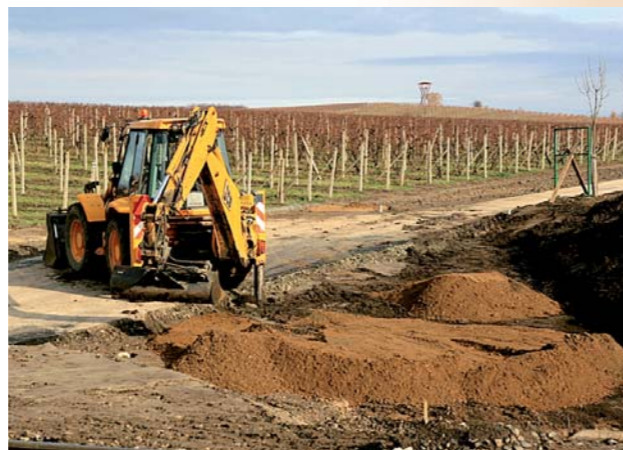
BUDOVÁNÍ ODVODŇOVACÍHO KANÁLU U ZASTÁVKY ČD
